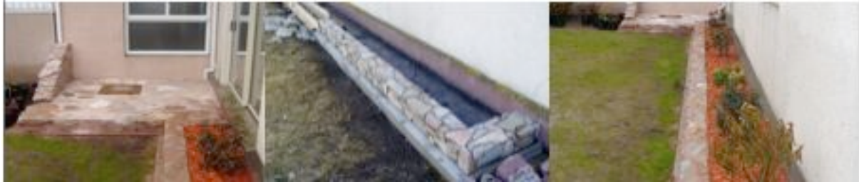
Dallage et jardinière en granite des îles réalisé pour un client de St-Pierre
